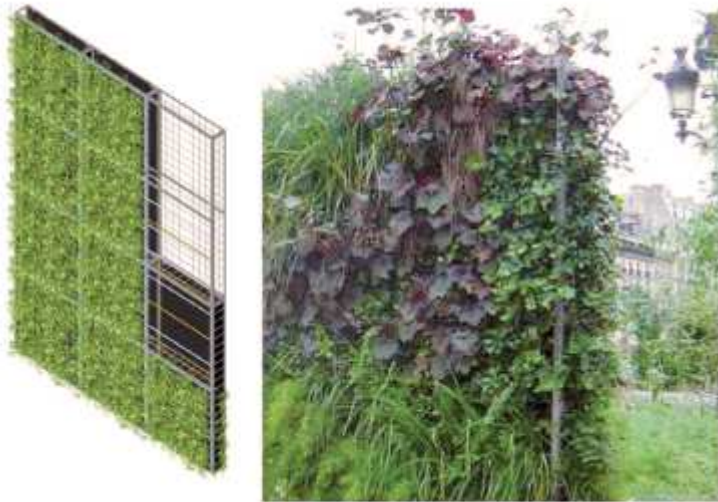
Figur 11. Figuren visar uppbyggnaden av en grön bullerskyddsskärm (t.v) och en uppbyggd grönskade bullerskyddsskärm (t.h).
