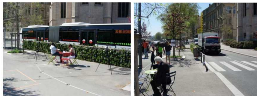
Figur 10 Bild från testområde i Lyon med vägnära bullerskyddsskärm.
