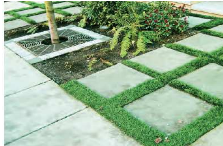
Figur 7. Figuren visar bild från MKB från projekt Mälärporten. Bilden är ett förslag till hantering av dagvatten genom att gröna partier vävs in i gatuutrymmet.
